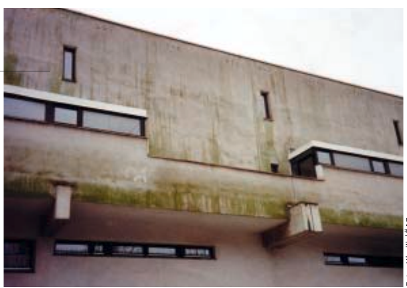
Bild 4: Stark befallene, witterungsbelastete Fassadenflächen, trocken gebliebene und deswegen nicht veralgte Flächen unter Vorsprüngen und Verblechungen
