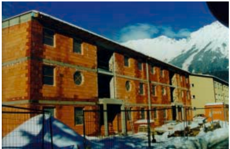
Beim Einhausen von Rohbauten, die in der kalten Jahreszeit innen zu verputzen sind, ist auch die Belastung des Mauerwerks z.B. durch schmelzenden Schnee und noch fehlende Regenleitungen zu beachten.
